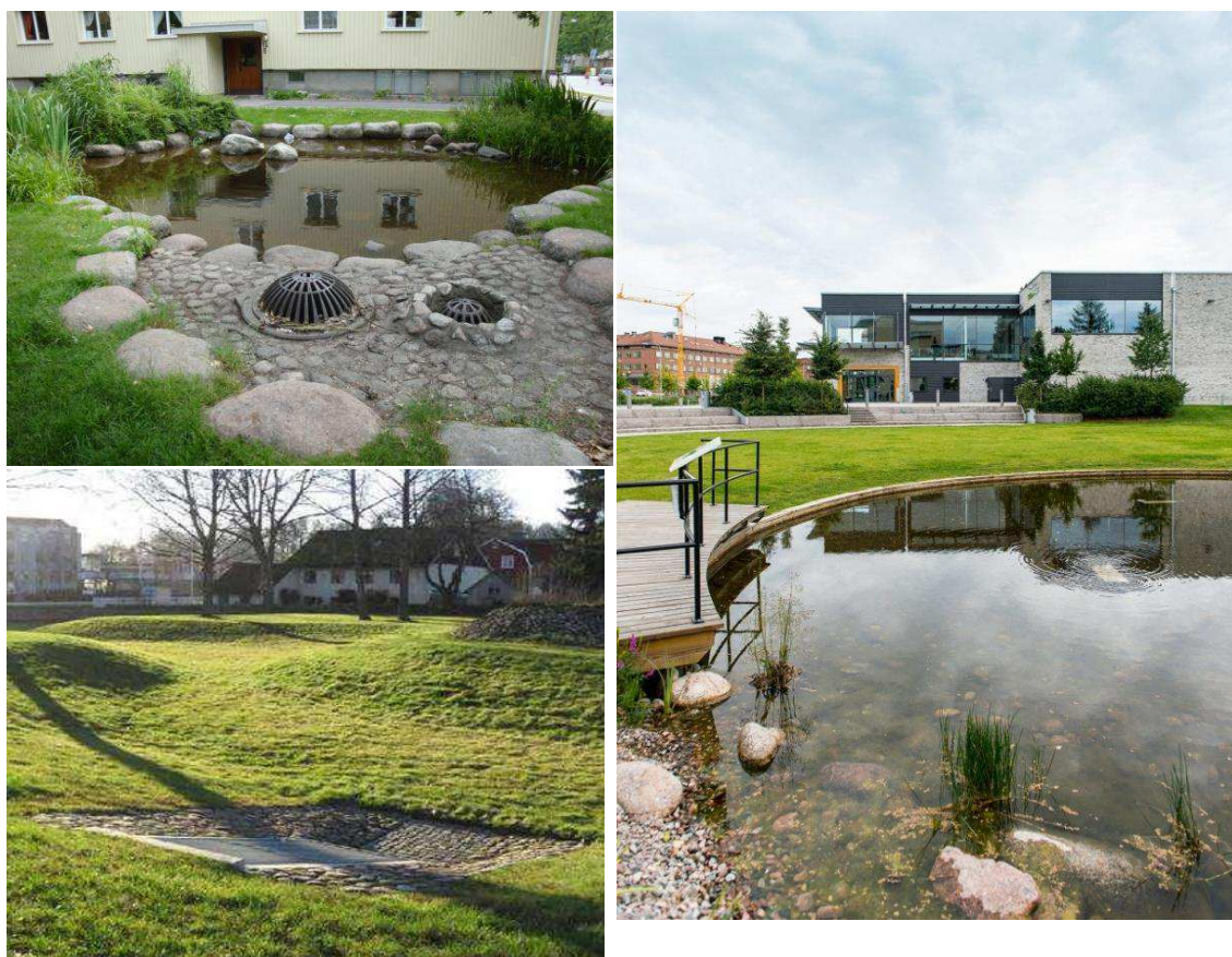
Figur 3. Exempel på dagvattendammar och en översvämningsyta.
